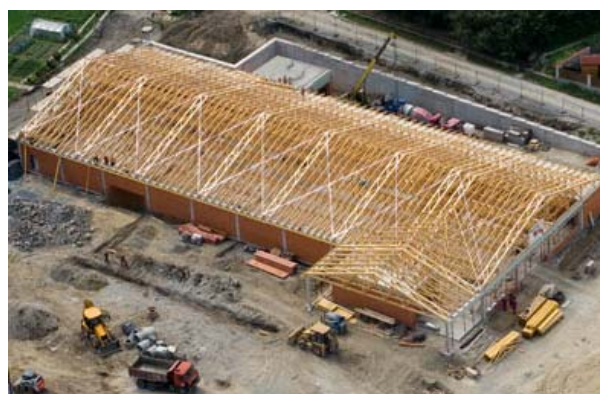
Obr. č. 1 – Princip fungování ztužidla a příklad realizace
